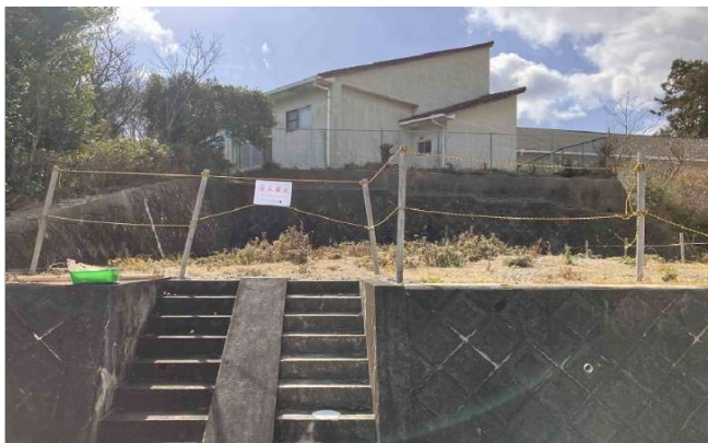
1 道路から物件を望む
