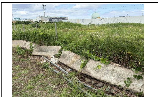
5 西境界、擁壁の状況
