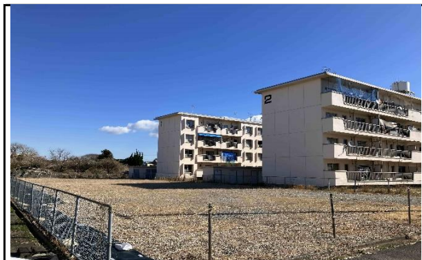
2 道路（南南西）から敷地を望む
