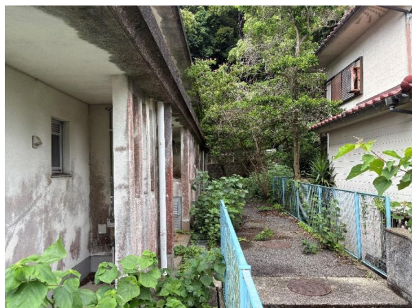
南東側より撮影
