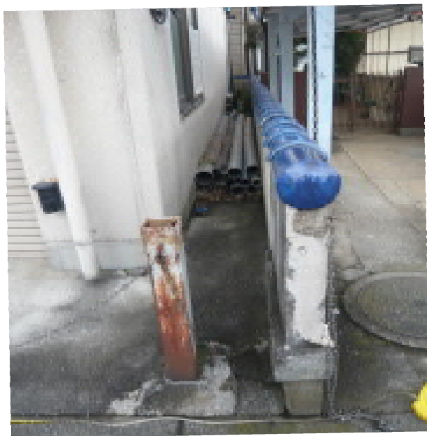
南東側 階段①
